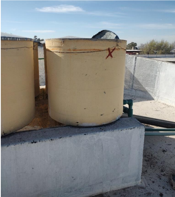
SANITARIOS ESTE/OESTE – BASE DE TANQUES
