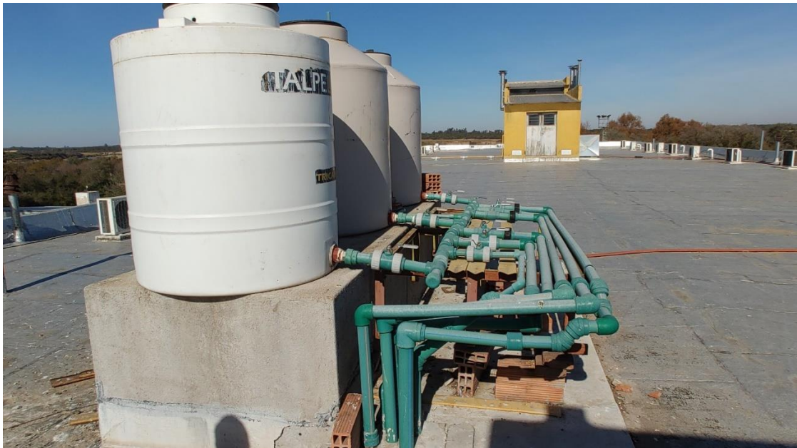
EDIFICIO DE MICROBIOLOGIA – VISTA GENERAL
