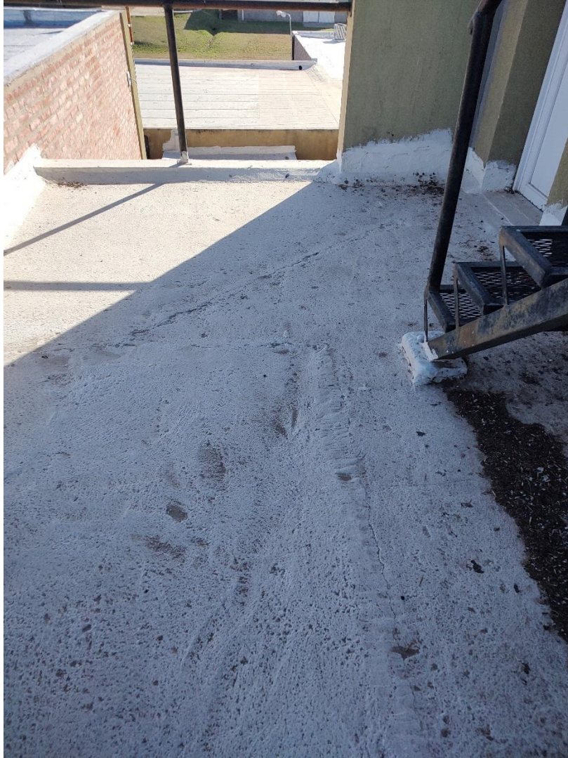
PLANTA PILOTO – ACCESO A TANQUES
