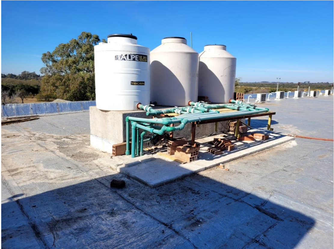
EDIFICIO MICROBIOLOGIA – SECTOR TANQUES
