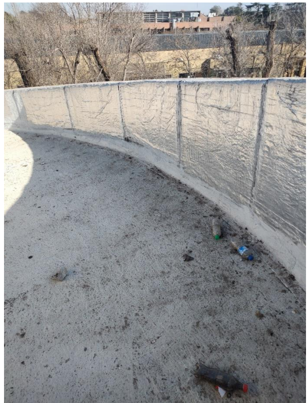
SANITARIOS ESTE/OESTE – VISTA GENERAL
