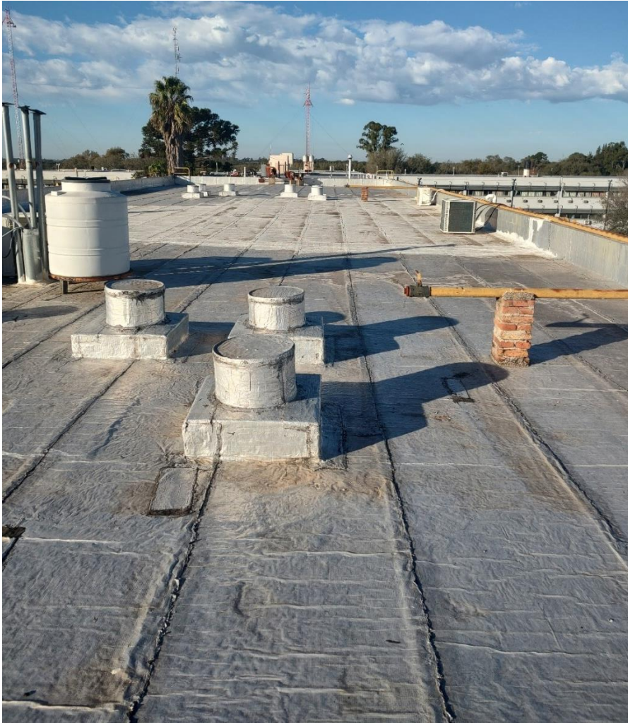
COMPLEJO AULAS COMUNES /AULAS 3 – VISTA GENERAL
