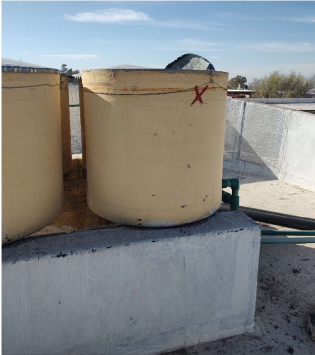
SANITARIOS ESTE/OESTE – BASE DE TANQUES
